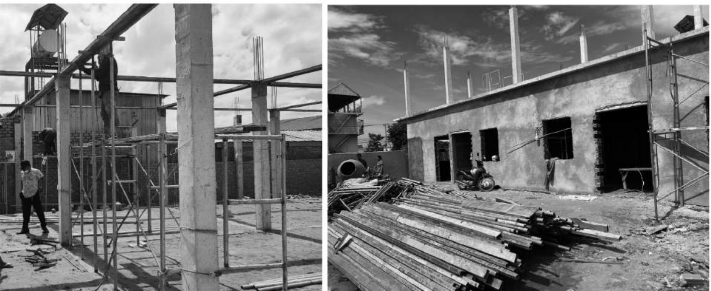
CHA新施設建設の様子 その2
